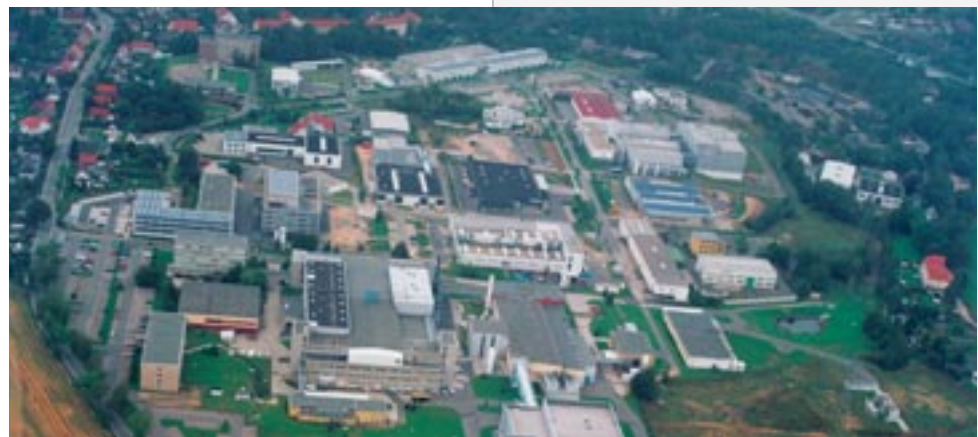
Hat sich rasch zum High-tech-Standort Freibergs entwickelt: das Gewerbegebiet Süd. Foto: BAF/Foto-Korb
