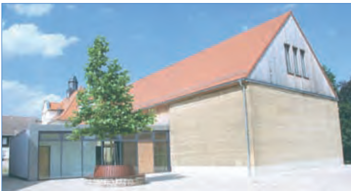
Kulturscheune im Ortsteil Börtewitz
