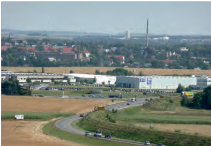
Blick auf das Gewerbegebiet Burgstädter Straße
