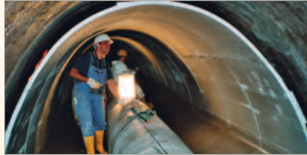
Bild 20 – Münzbach-Sammelkanal 2004, Montage der Auskleidungssegmente und der Münzbachleitung, Los 2
