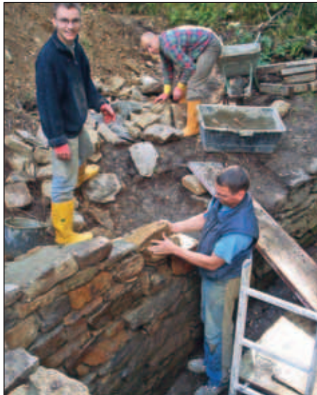
Natursteinmauerung am zuvor in geschlossener Bauweise verrohrten Durchlaß des Stangenbergbaches bei Muldenhütten
