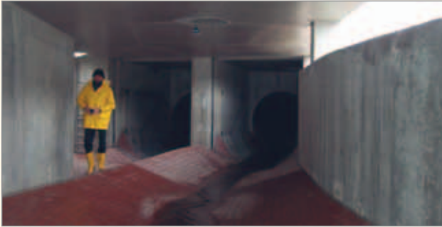
Bild 18 – Regenrückhaltebecken (RÜB) Hornmühlenweg 2004, Stauraumkanal 2 x Ø2400, 2004 in Betrieb genommen
