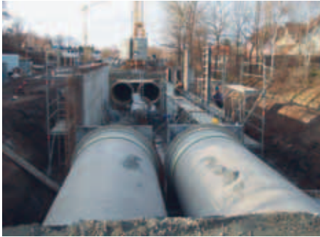
RÜB Hornmühlenweg Staukanal 2 x DN 2400 V = 2140 m 3
