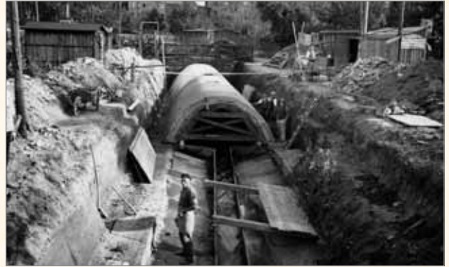
Bild 3 – Münzbach-Sammelkanal, Bau der Überwölbung in Ortbeton
