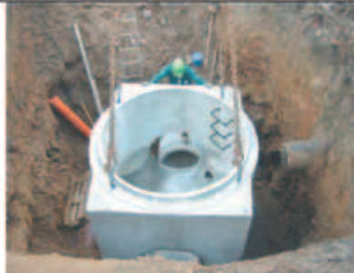
Schachtbauwerk Regenwasser-sammelkanal B 101 (Leipziger Straße)
