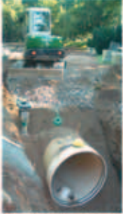
Im Zuge der Erneuerung Goldbachleitung und Offenlegung des Goldbaches im Alberpark erfolgte die Erneuerung des Saubach-Sammelkanals im Bereich Düker Chemnitzer Straße
