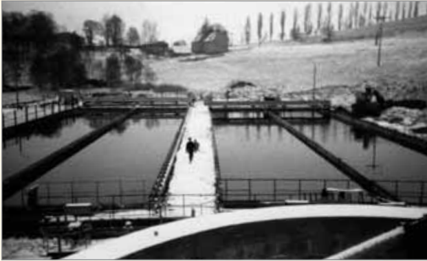
Bild 9 – Zentralkläranlage Freiberg 1991, Klärbecken der mechanischen Reinigung, 1989 in Betrieb genommen
