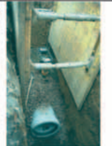
Kanalbau Annaberger Straße
