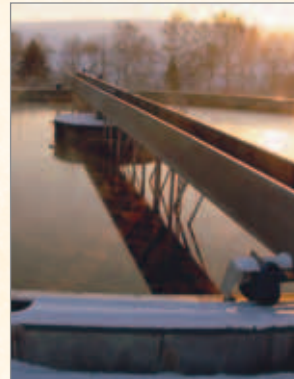
Bild 27 – Zentralkläranlage Freiberg 2006, Nachklärbecken, 1998 in Betrieb genommen
