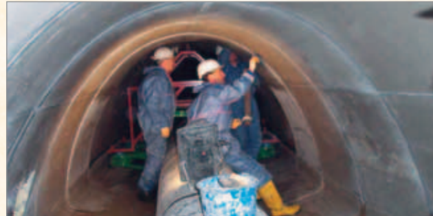
Bild 21 – Münzbach-Sammelkanal 2004, Verfügen der Auskleidungssegmente, Los 2
