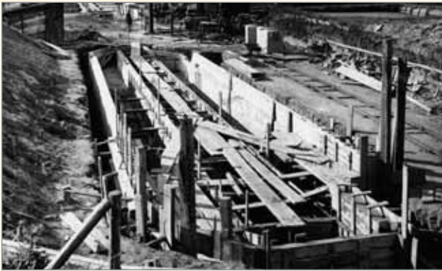
Bild 4 – Kläranlage am Hornmühlenweg 1934, Bau des dreiteiligen Sandfanges
