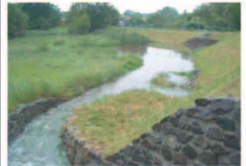
Naturnaher Regenrückhalteteich Leipziger Straße
