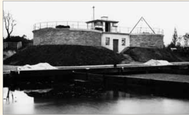
Bild 5 – Kläranlage am Hornmühlenweg 1934, Schlammfallbehälter mit 2 x 500 m 3 Fassungsvermögen
