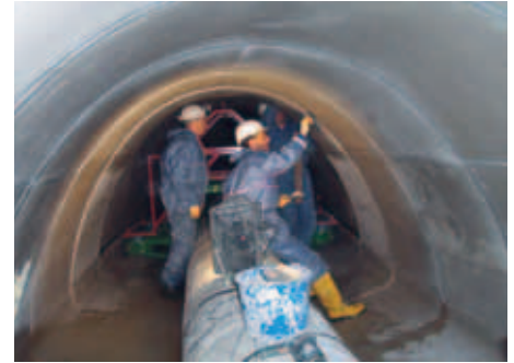
Sanierung Münzbach-Sammelkanal Maulprofil 4200 x 2200
