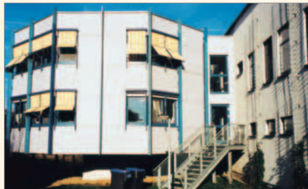
Bild 17 – Zentralkläranlage Freiberg 2000, Verwaltungsgebäude des Eigenbetriebes FAB, 1998 in Betrieb genommen
