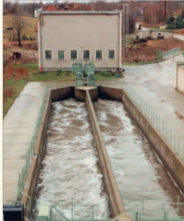
Bild 10 – Zentralkläranlage Freiberg 1994, Sandfang, 1989 in Betrieb genommen, im Hintergrund das Rechenhaus und die Einfahrt
