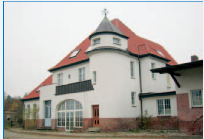
Bahnhof in Börnicke
