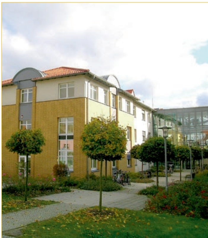
Verwaltungsgebäude des Landkreises, Papendorfer Weg 1 in Belzig
