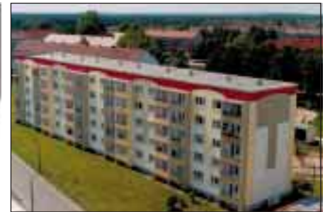
Karl-Liebknecht-Str. 27-35 Am Giebel wird der Neubau entstehen (Ecke Erich-Weinert-Str.)
