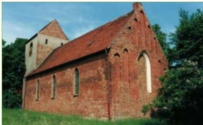
Dorfkirche um 1300, 1945 ausgebrannt, danach Wiederaufbau
