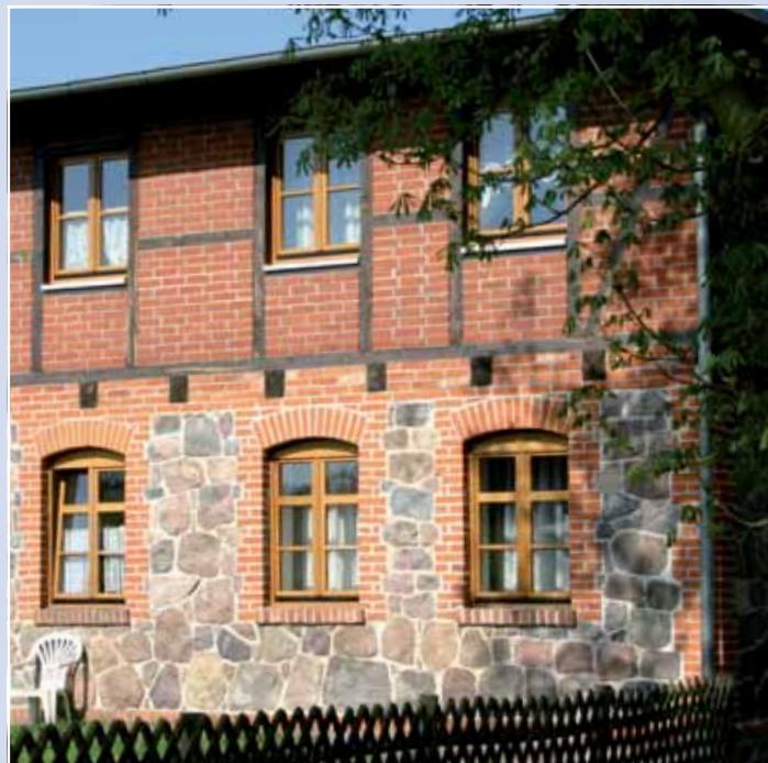
Saniertes Haus in Wilkendorf
