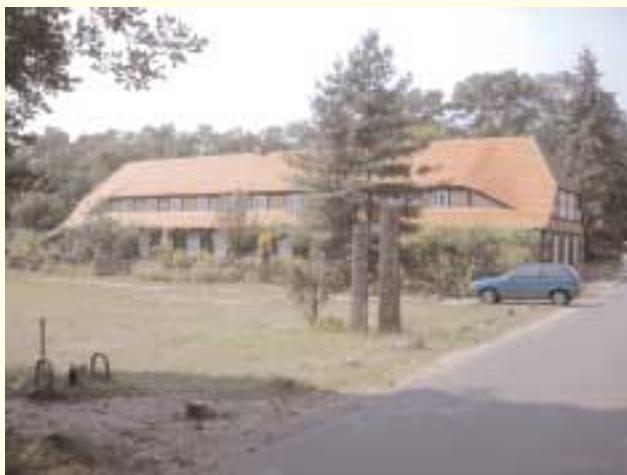
Fachwerkhaus in Glashütte
