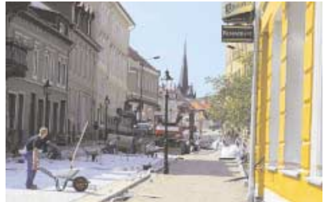
Bauarbeiten am 3. Bauabschnitt der Hauptstraße
