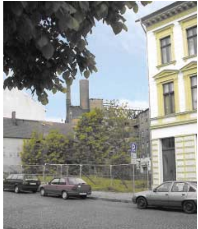
Die Baulücke, entstanden durch den Abriss des ehemaligen Zentralhotels mit der angrenzenden Ruine der Malzfabrik, gehört zu den neu zu ordnenden Problembereichen der Stadt – eine Aufgabe der nächsten Jahre.
