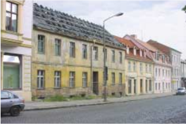
Das Wohnhaus Karl-Marx-Straße 12 wird sich nach einer dringend erforderlichen Bestandssicherung und Sanierung wieder in das Bild der Hauptstraße einfügen.
