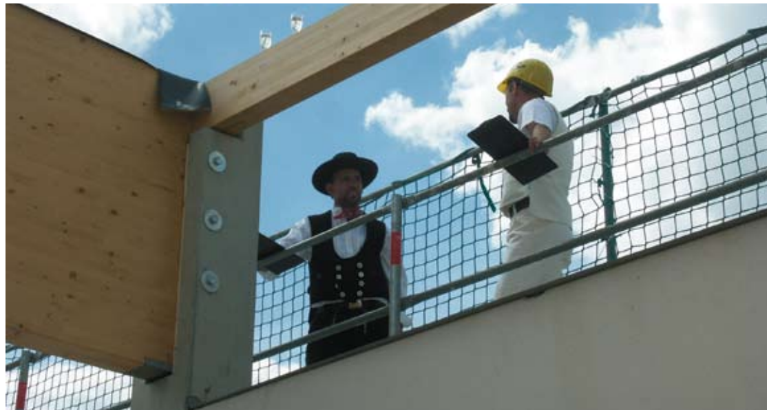
Leimholzbinder in der Sporthalle (Geb. 99)
