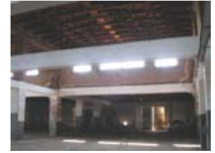
Hörsaalgebäude vor dem Umbau
