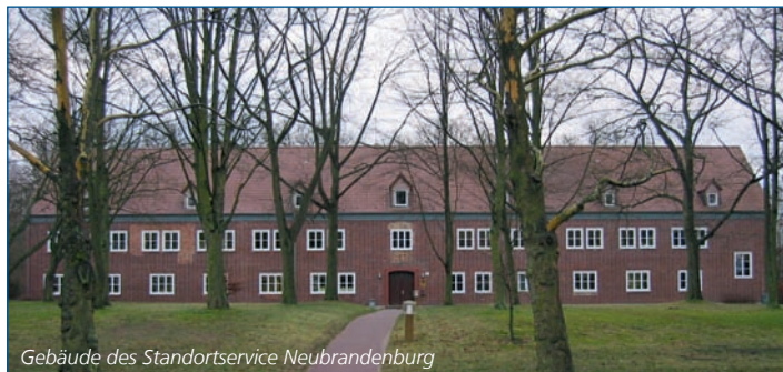
Gebäude des Standortservice Neubrandenburg
