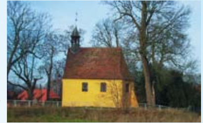
Kleine Kapelle in Reez ca. 1800 klassizistischer Baustil
