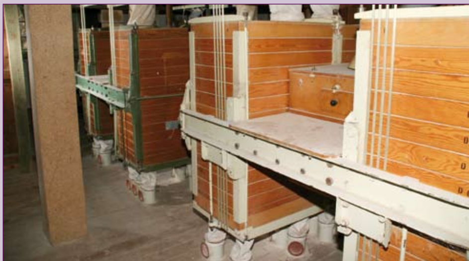
Die Plansichter der Wassermühle
