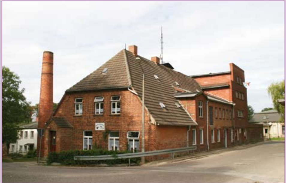
Die historische Wassermühle wartet nach Umbauarbeiten auf einen Müllermeister.
