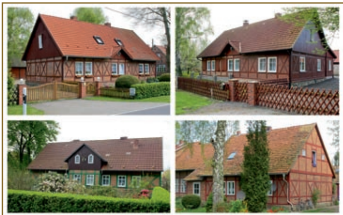
Gut erhaltene Ziegelfachwerkhäuser
