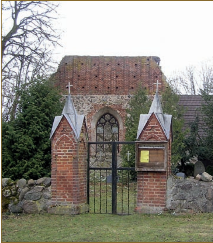
Kirchenruine Rolofshagen (Sanierung seit 08/2006)
