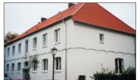
Modernisierung und Instandsetzung Franzburg
