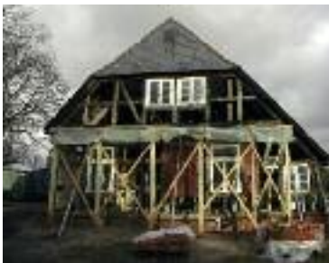
Ehemaliges Pfarrwitwenhaus Anfang 19. Jh. Gemeinde Neuhaus-Stapel Sanierung/Instandsetzung des Fachwerks
