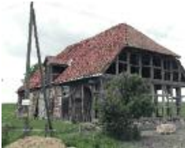
Scheune der ehemaligen Deichvogtei von 1802 Gemeinde Neuhaus-Brandstade Sanierung/Instandsetzung des Fachwerks
