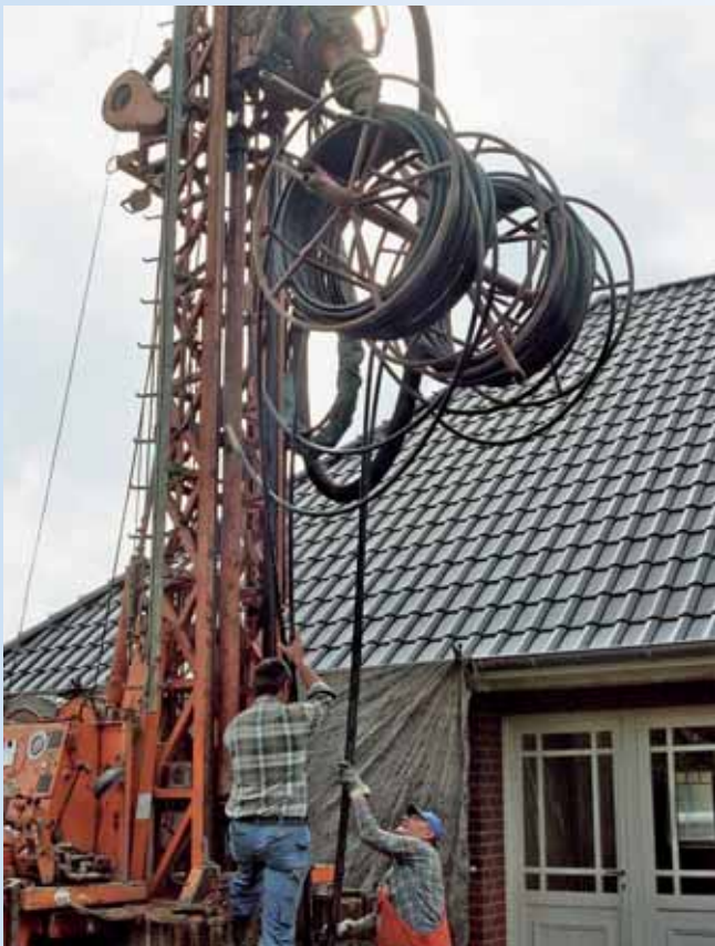
Haus Familie Streichert: Bohrung der Erdwärmesonde
