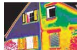
Fassade gedämmt ungedämmt
