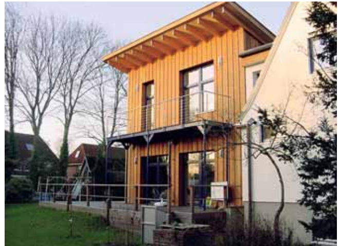
Sanierung es Dreißigerjahre Altbaus zum Niedrigenergiestandard, Anbau in Passivhaus-Bauweise; Quelle: Heinicke
