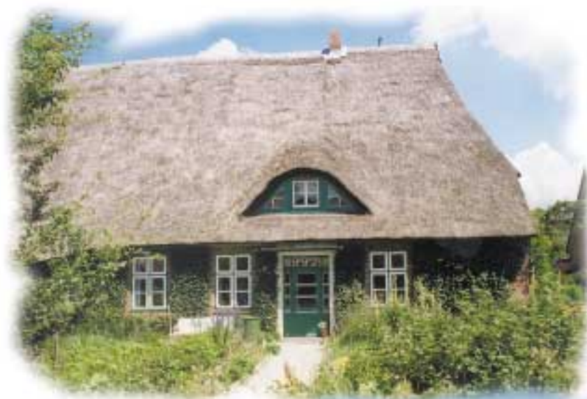
Wohnhaus in Bälau
