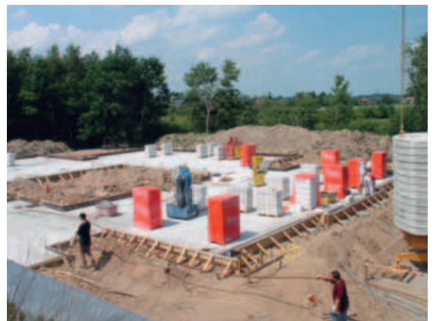
Erweiterung der Hachede-Schule Geesthacht
