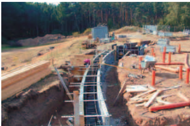
1. Erweiterung der Schule Steinfeld in Mölln
