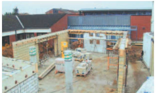
1. Erweiterungsbau der Schule Steinfeld, Mölln
