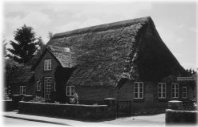
Westerrönfelds erstes Schulgebäude, heute ein schmuckes Einfamilienhaus.
