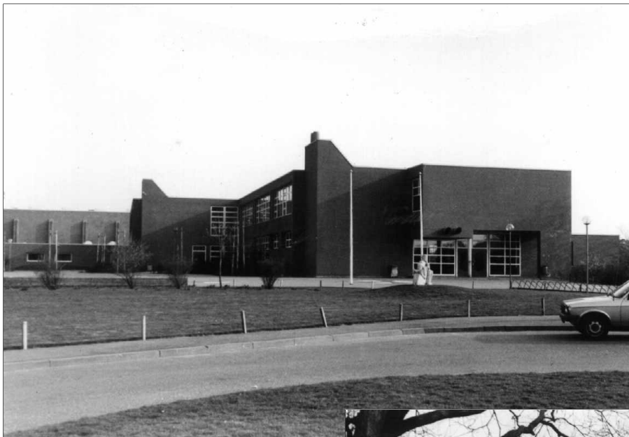
Grund- und Hauptschule mit Großsporthalle
