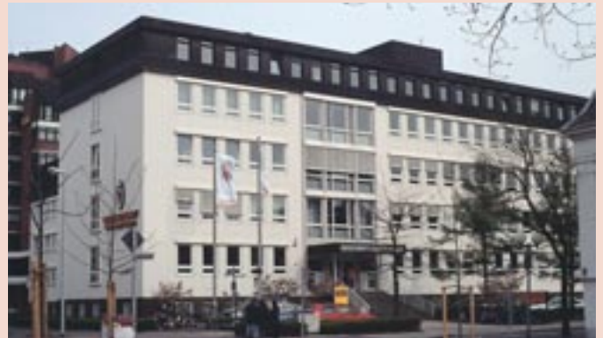
“Gegenseitigkeitshaus” an der Osterstraße 15
