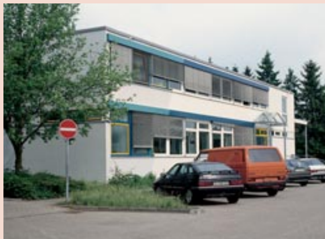
Bürgerbüro Nord am Stillen Weg
