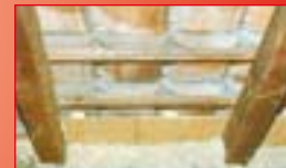
Dämmung einer Dach- schräge (mit Hinterlüftung)
