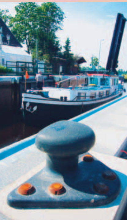
Schleuse Kukulorum, Stadt Aurich
