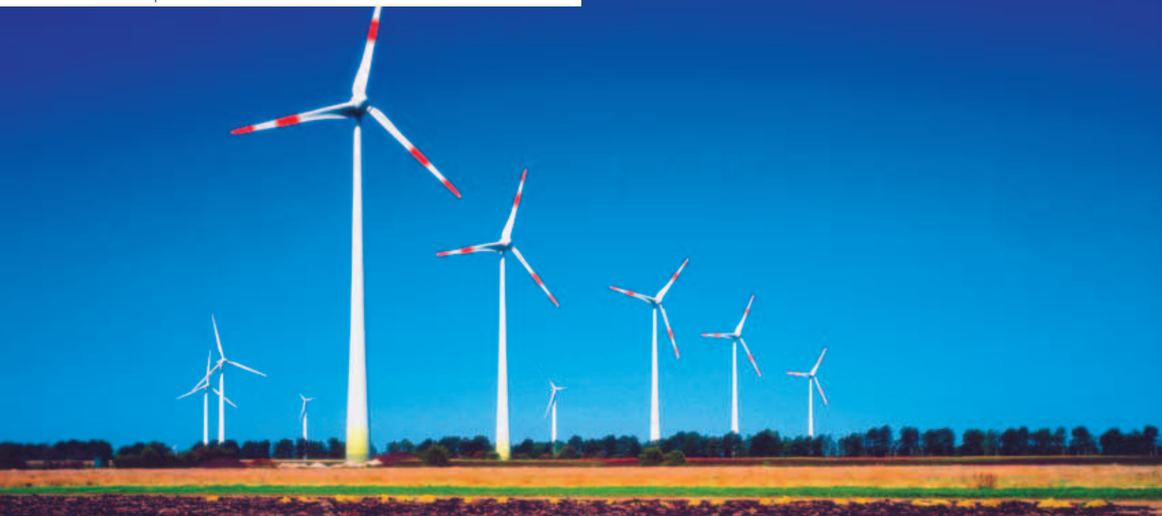
ENERCON – E70-Windpark Scharrel
