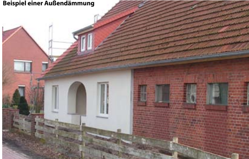
Beispiel einer Außendämmung
