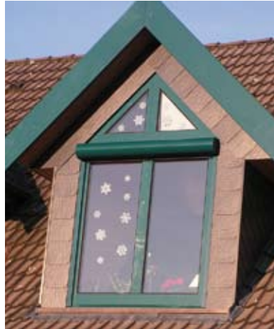
Nachträglich vorgebauter Rollladen
