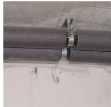
Isolierte Heizungsleitung
