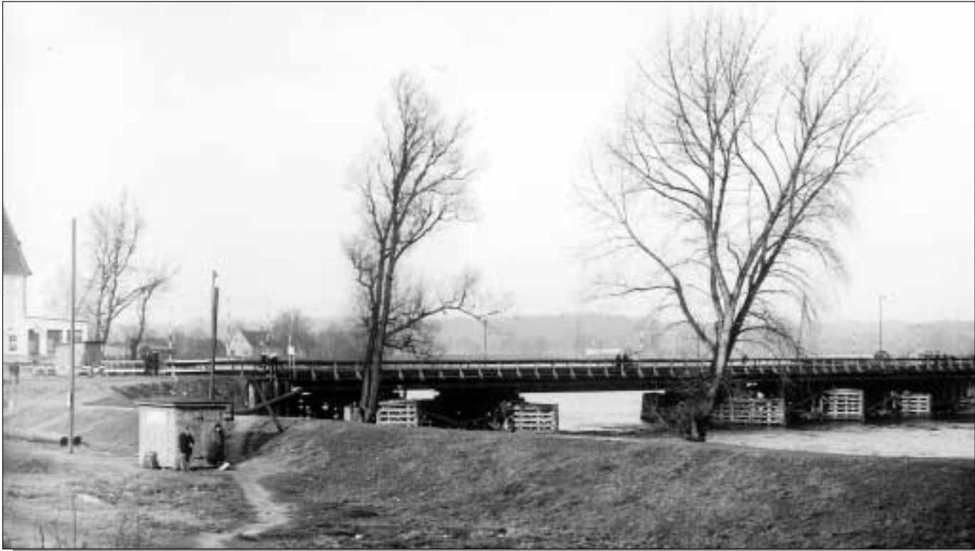
Notbrücke in Burg
