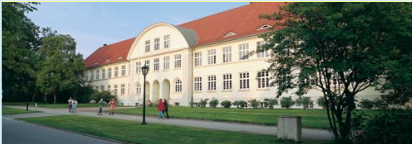
Grund- und Hauptschule in Wittingen
