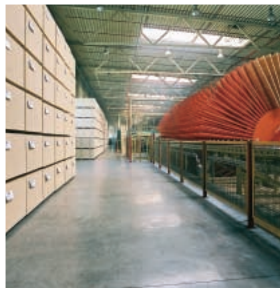
Plattentrockner der Glunz AG, Tray dry oven at Glunz AG
