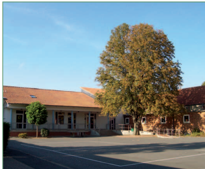
Grundschule in Ahrbergen
