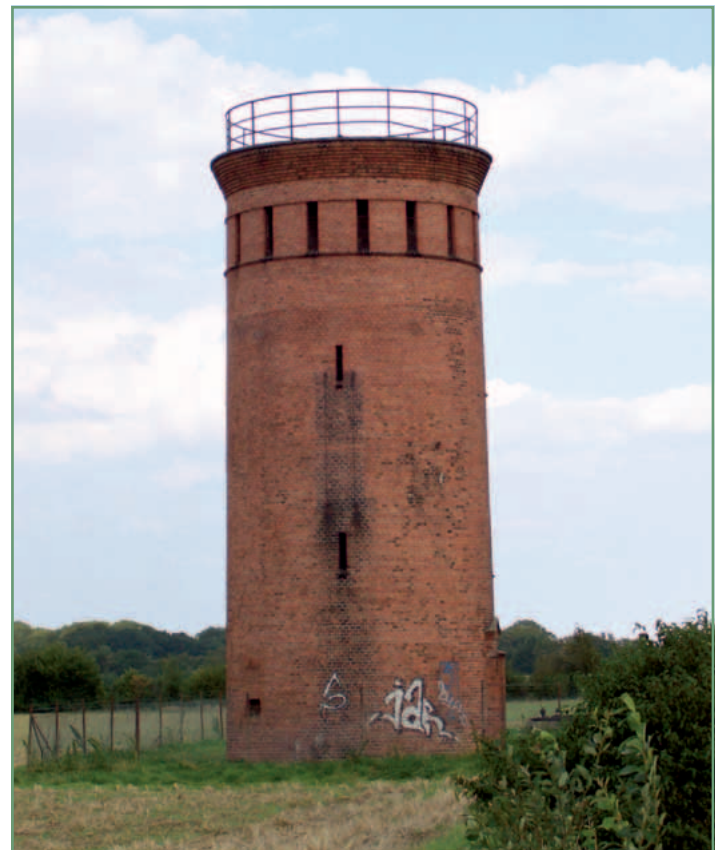
Historischer Wasserturm in Hasede
