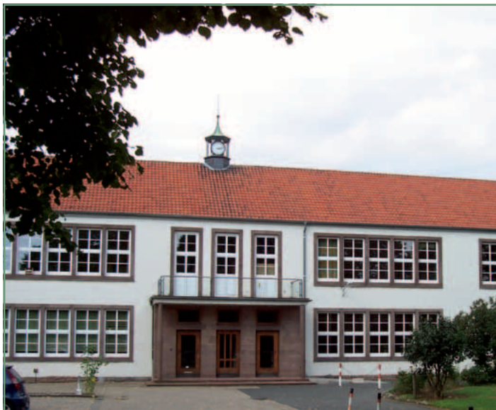
Grundschule in Giesen
