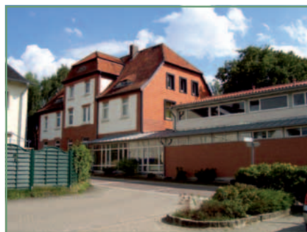
Grundschule in Hasede
