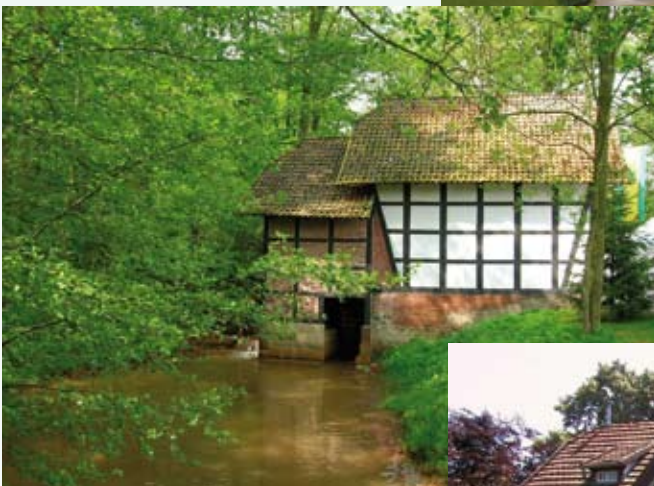
Wassermühle in Harriestedt, Gemeinde Raddestorf
