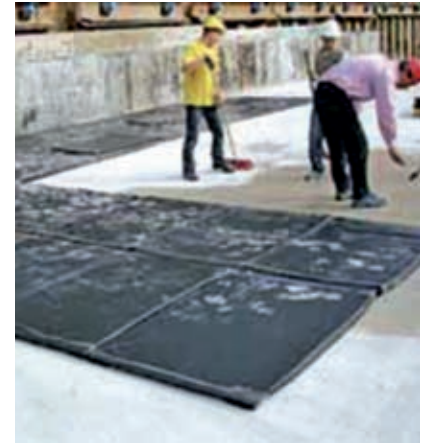
Montage in München: Das Prestigeobjekt Lenbach-Gärten ruht auf Lagern von Calenberg Ingenieure.
