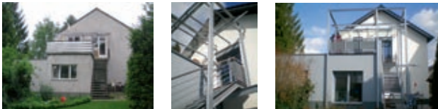
Wohnhaus in Paderborn Zentrum, vor und nach dem Umbau
