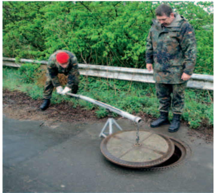
WmTrp Kassel bei der Kontrolle einer Straßensprengschachtanlage
