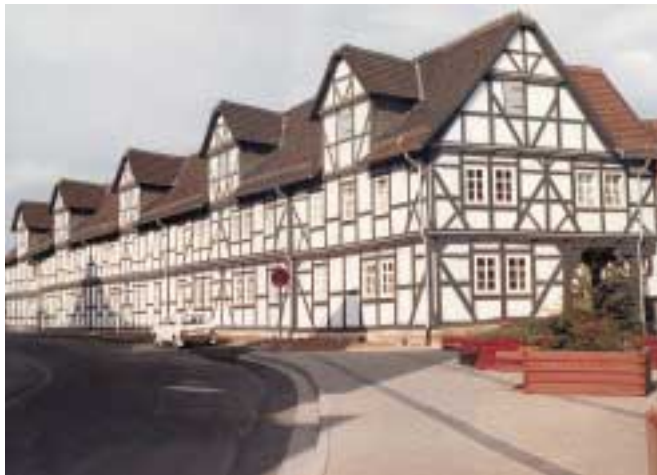
Sanierung: Hospital Gudensberg
