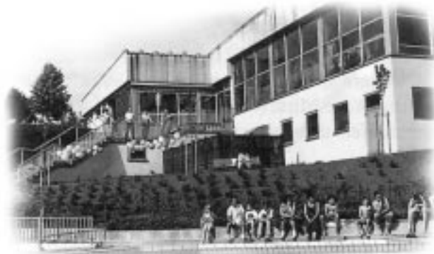
Hallen- und Freibad mit Sauna und Solarium
