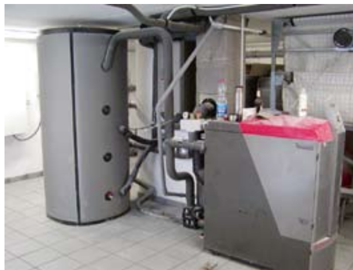
Holzpelletsheizung mit Pufferspeicher
