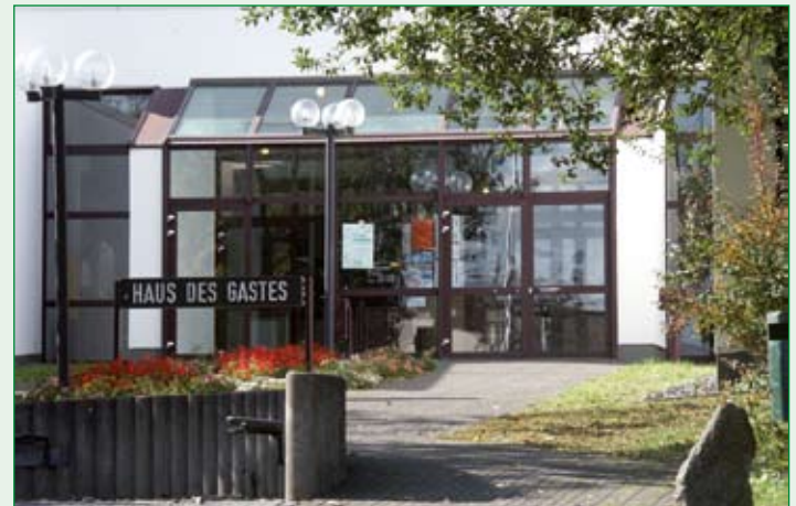
Eingang Haus des Gastes
