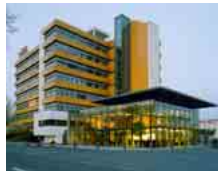
Eingangsgebäude Stadtwerke Giessen AG Leistungen aplus: Hochbau, Innenarchitektur, Möbel
