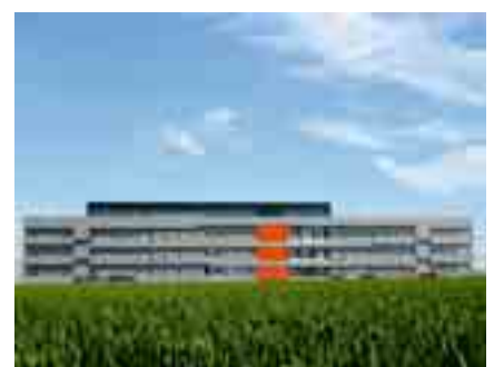
Bürogebäude und Produktionshalle, Bautec GmbH Leistungen aplus: Hochbau und Innenarchitektur
