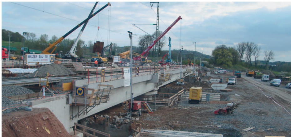
Bauarbeiten am Kreuzungsbauwerk A66 / DB Gemünden-Flieden
