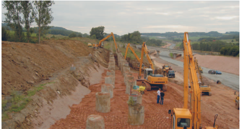
Bauarbeiten im Bereich der aufwendigen Hangsicherung, im Hintergrund die DB-Überführung
