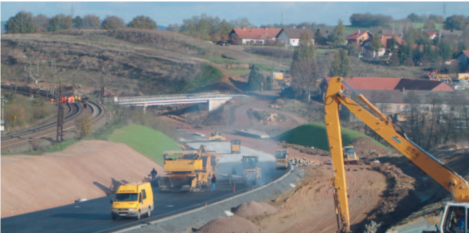
Erd- und Deckenbau mit Brücke und Lärmschutz bei Rückers
