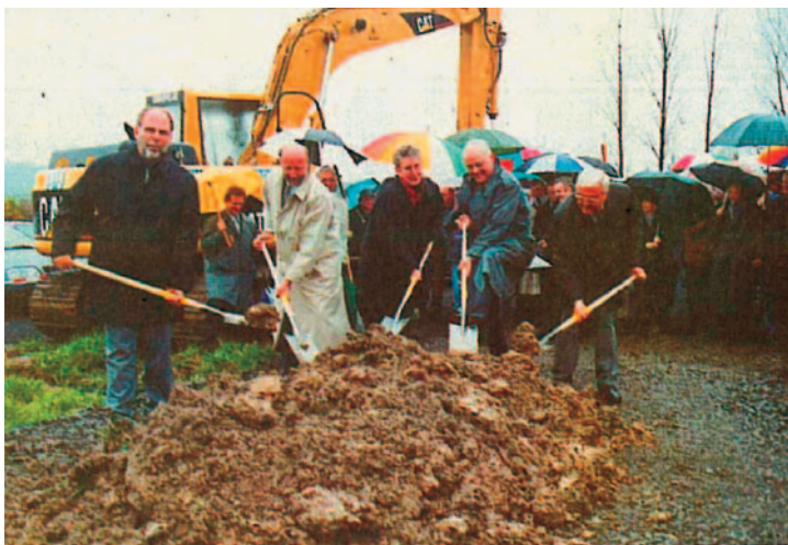
Beim ersten Spatenstich an der Gänse- trift (von links): Staatsekretär Siegfried Scheffler, Minister Dieter Posch, SPD-Landtagsabgeordnete Ilse Stiewitt, Landrat Fritz Kramer und Bürgermeister Winfried Kress
