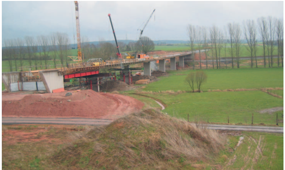
Bauarbeiten an der Anschlussstelle Neuhof-Süd / L 3206 und Fliedetalbrücke
