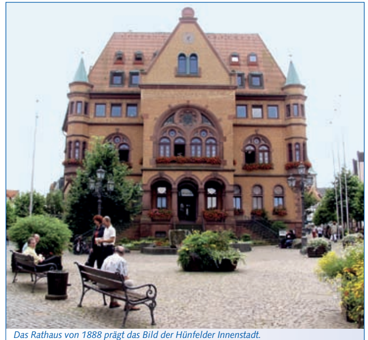
Das Rathaus von 1888 prägt das Bild der Hünfelder Innenstadt.
