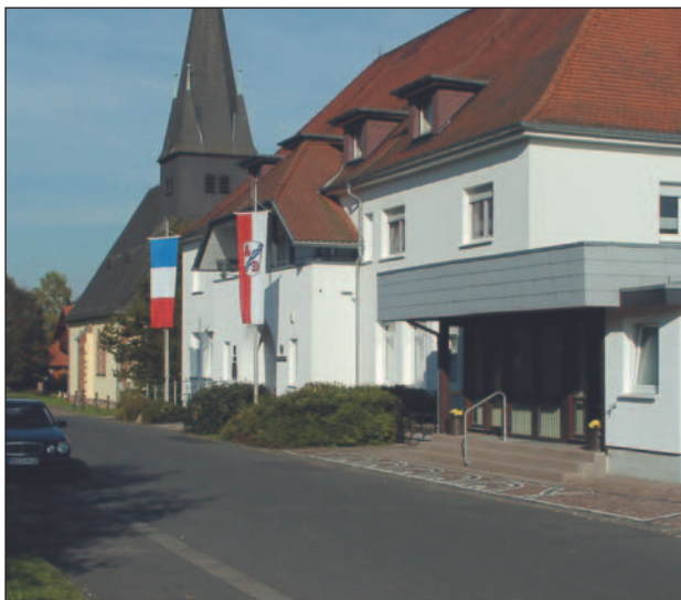
■ Das Verwaltungsgebäude der Gemeinde Ludwigsau im Ortsteil Friedlos, Schulstraße 1
