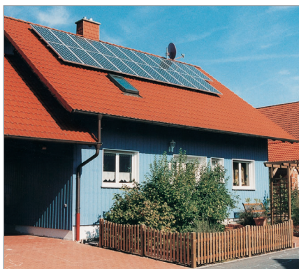
Wohnhaus im Neubaugebiet Niederaula Ortsteil Kerspenhausen
