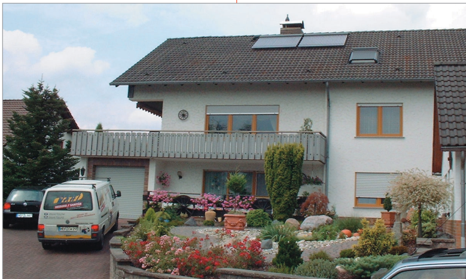
Wohnhaus mit thermischer Solaranlage (Röhrenkollektoren)
