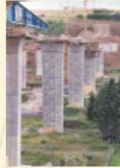
A 44 Hopfenbachtalbrücke (Hessen)
