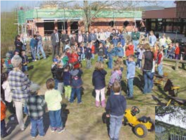
Richtfest Erweiterungsbau Kindergarten / April 2003
