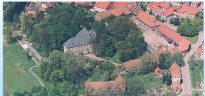
Schlossanlage in Rittmarshausen
