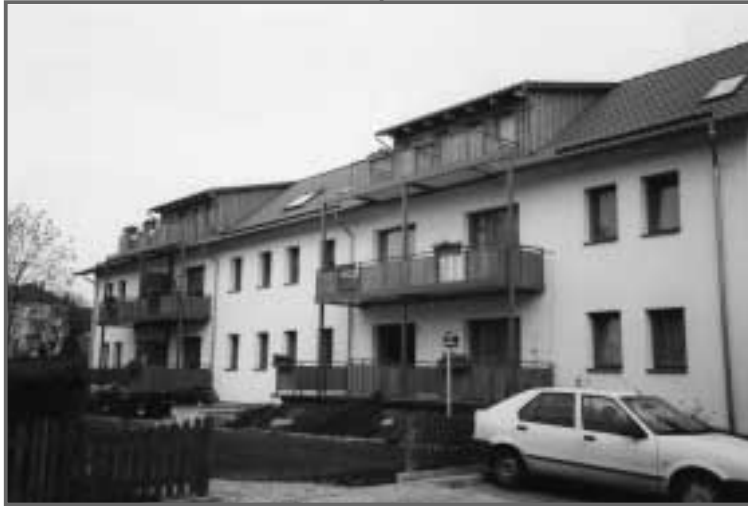
Sanierter Wohnblock in Worbis
