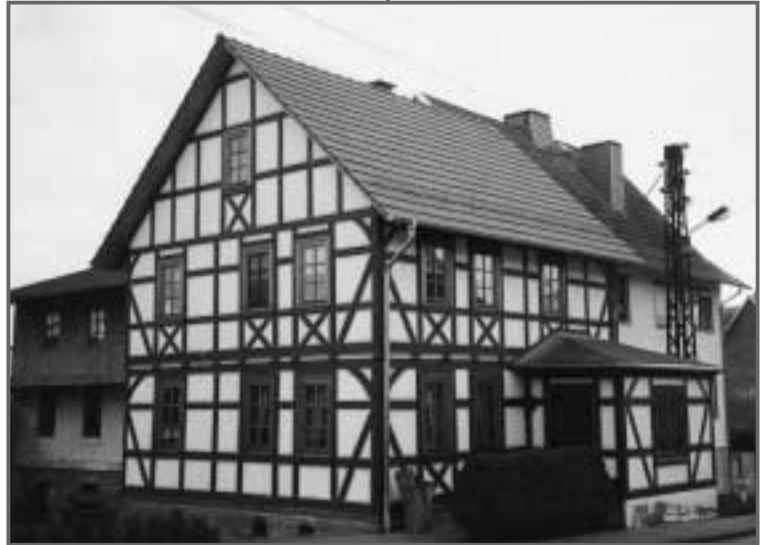
Saniertes Fachwerkgebäude in Rohrborg
