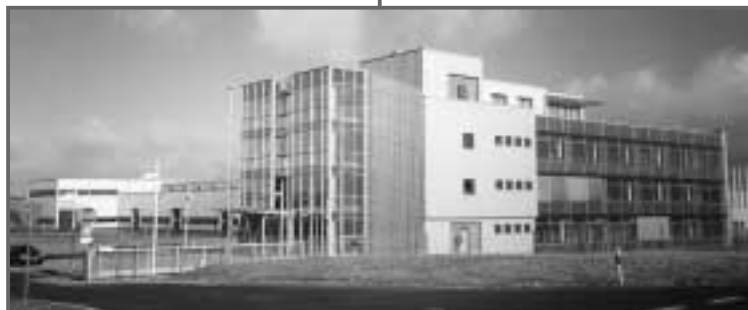
Neubau eines Produktionsbetriebes im Gewerbegebiet in Dingelstädt/Kefferhausen
