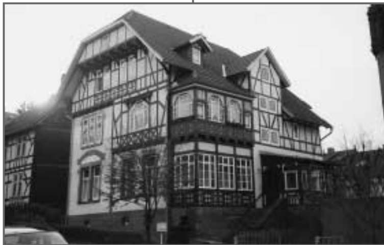
Saniertes Wohnhaus in Heiligenstadt
