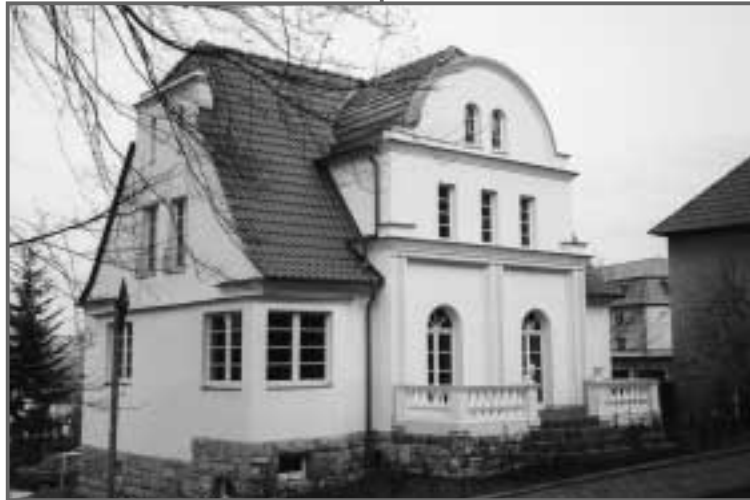
Saniertes Wohn- und Geschäftshaus in Heiligenstadt
