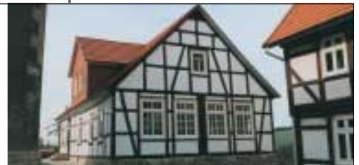
Objekt: Sanierung Jugendzentrum Weißenborn-Lüderode, Fertigstellung 1999
