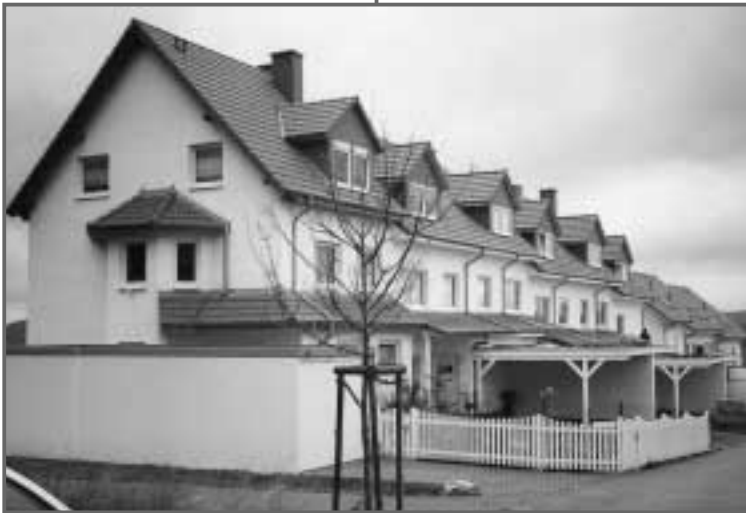
Reihenhausbebauung im Wohngebiet „Honiggrube“ in Heiligenstadt
