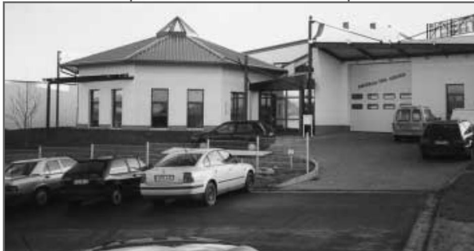
Neu errichteter Betrieb im Gewerbegebiet in Heiligenstadt
