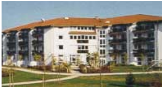
Alten- und Pflegeheim Bodenwerder
