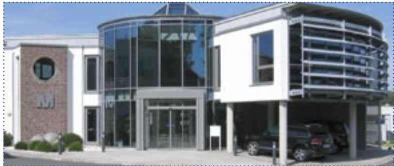
Das neue Verwaltungsgebäude der Gustav Meister entstand 2003 nach nur 7-monatiger Bauzeit.
