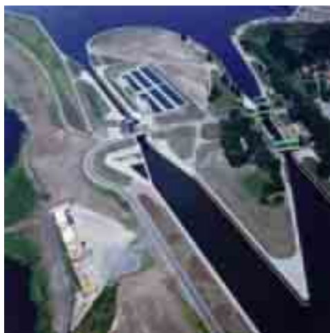
Sparschleuse und Schiffshebewerk Rothensee
