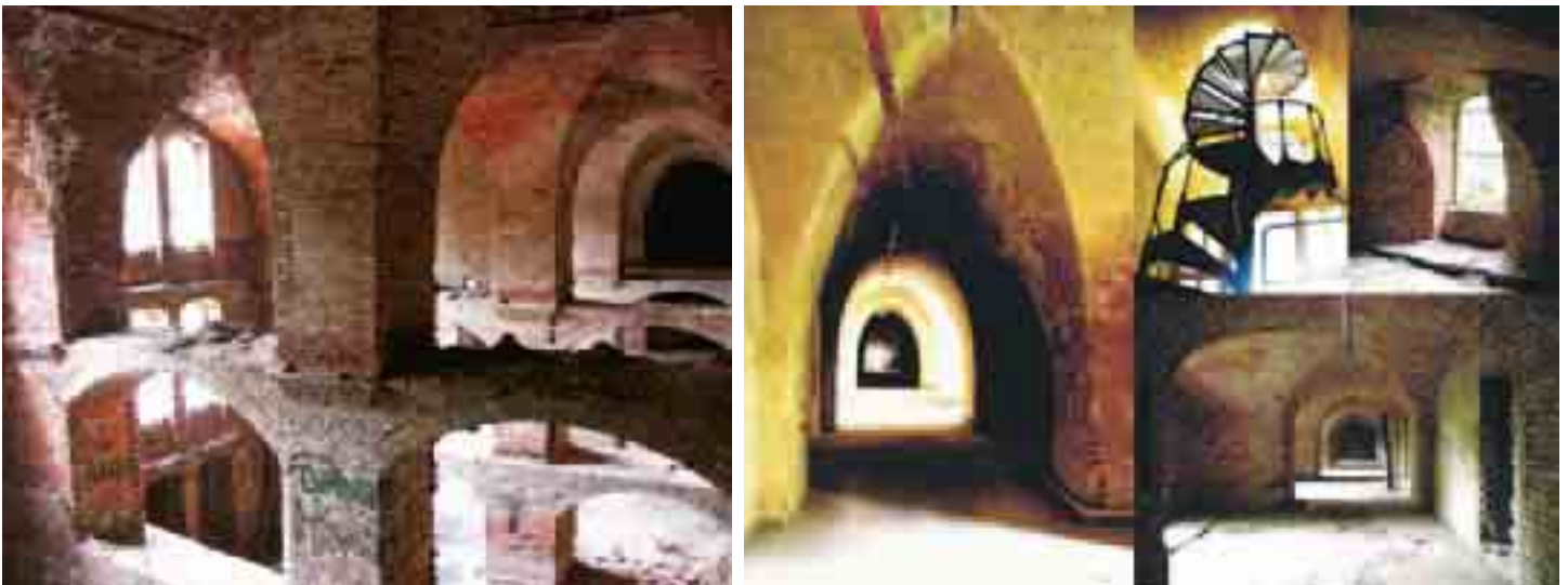
Kaserne Mark – Innenansichten
