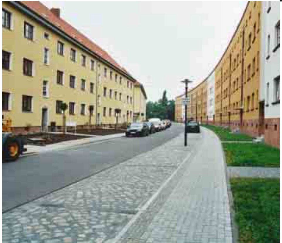
Siedlungsstraßenbau 2004 – Bunsenstraße nach Reko 2004
