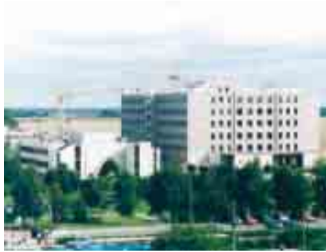
Das Krankenhaus Olvenstedt im Jahr 2001. Die Bauarbeiten am chirurgischen Bettenhaus und OP-Gebäude auf der Nordseite sind im vollen Gange.
