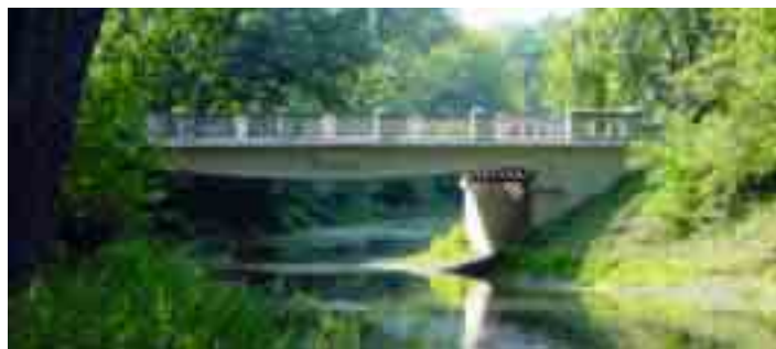
Reyherbrücke im Stadtpark Rotehorn
