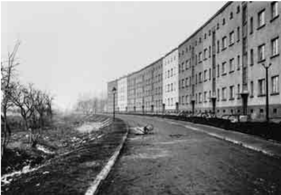
Siedlungsstraßenbau 1934 Bunsenstraße Ostseite von der Curiestraße aus gesehen im Aufbau, Westseite fehlt noch.
