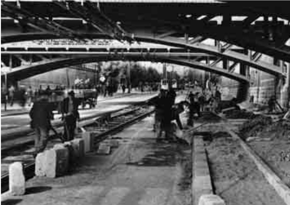
Kombinierter Straßen- und Gleisbau 1941 Kölner Straße in Höhe Kölner Platz, Blickrichtung West
