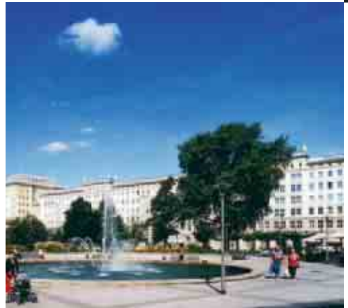
Von der Wobau saniert: Ernst-Reuter-Allee in der Magdeburger Innenstadt
