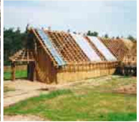
Rekonstruktion eines Schönfelder Pfostenhauses (Endneolithikum) am Dorfrand von Randau
