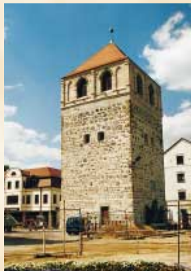
Der „Dicke Turm“ nach der Sanierung
