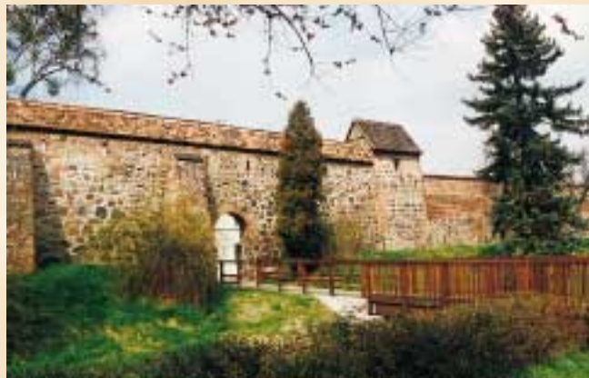
Marienforte, nördl. Ansicht nach der Sanierung
