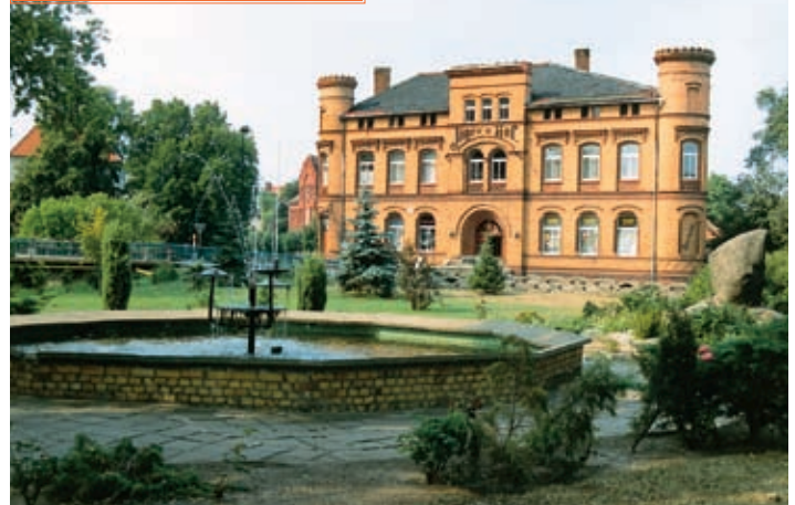
Parkanlage Oebisfelde mit Jägerhof
